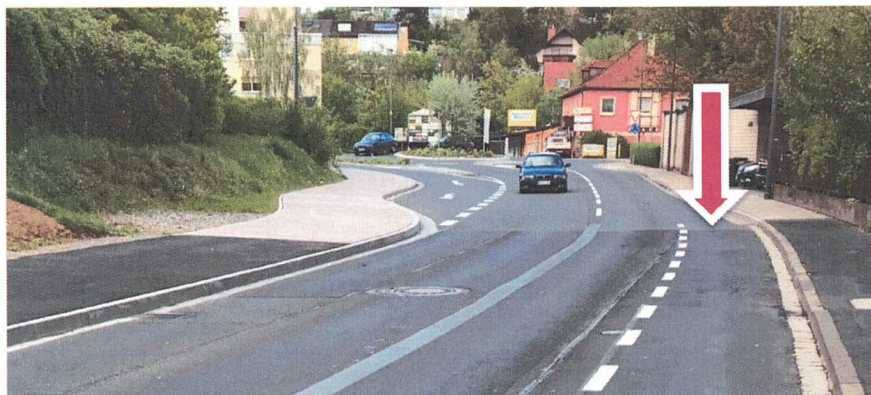
Abb. 6 Fehlender Schutzstreifen Stadtauswärts
